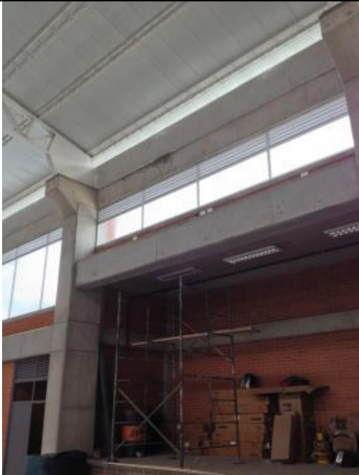
Humedad no controlada en viga canal eje F (3 -4) y Vista Exteriores
